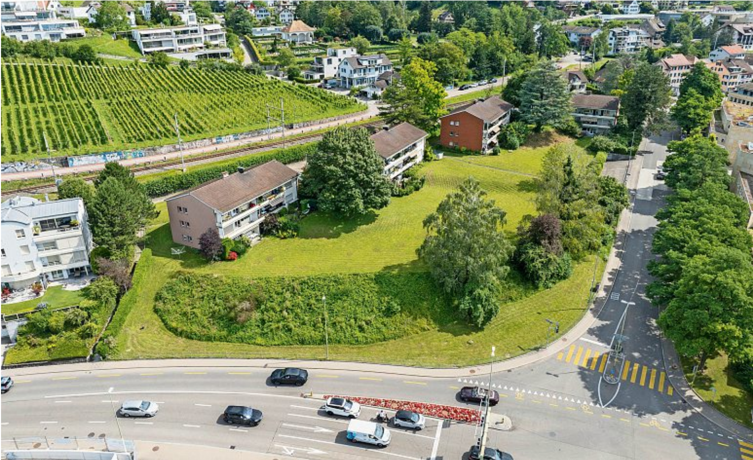
Auf diesem Grundstück zwischen Seehaldenweg, Dorf- und Seestrasse soll neu gebaut werden: Die vier Mehrfamilienhäuser werden dafür abgebrochen. Foto: Michael Trost
